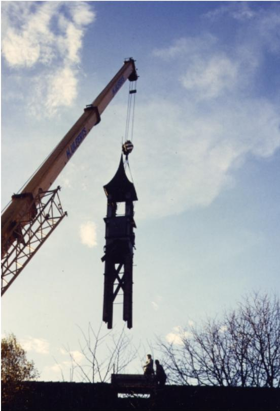
*Der alte Dachreiter wird von einem mächtigen Kran aus dem Kirchendach gehoben (oben). Der neue Dachreiter wird gebaut (rechts). Die Kanzel ist zum Schutz während der Kirchenrenovierung innen verpackt (unten).*
