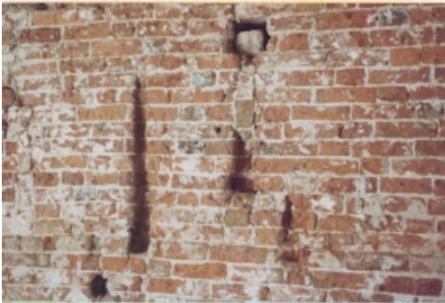
Alte Mauerspuren unter dem abgeschlagenen Putz in der Kirche
