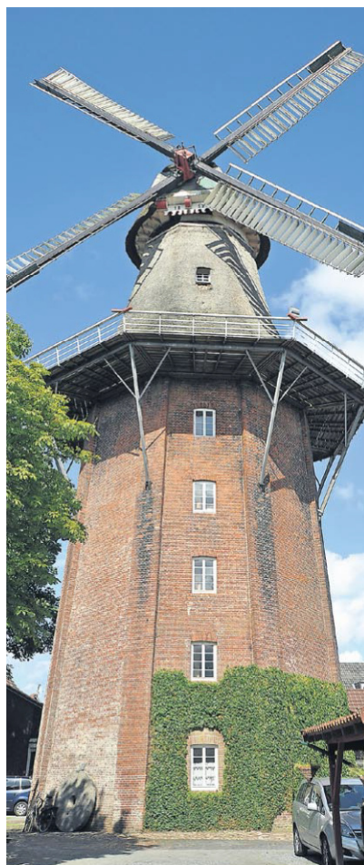
Der „Sturmseite“ zugewandt: Die Mühlenkappe wurde mit den Flügeln nach Nordwesten ausgerichtet und fixiert.
