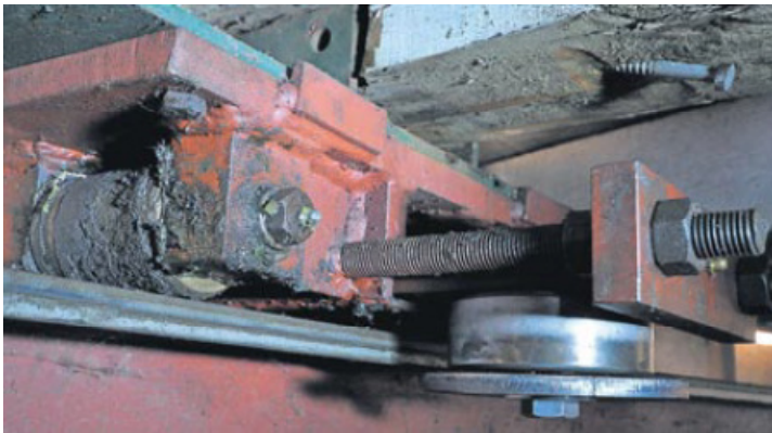
Leisten Schwerstarbeit: Acht dieser Rollenlager tragen die 16 Tonnen schwere Mühlenkappe auf dem Zahnkranz.
